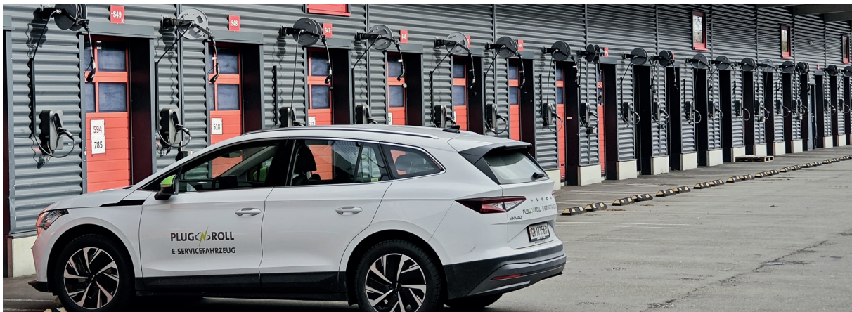
Standort Buchs: 54 interaktive AC Ladestationen mit jeweils 22 kW Leistung
